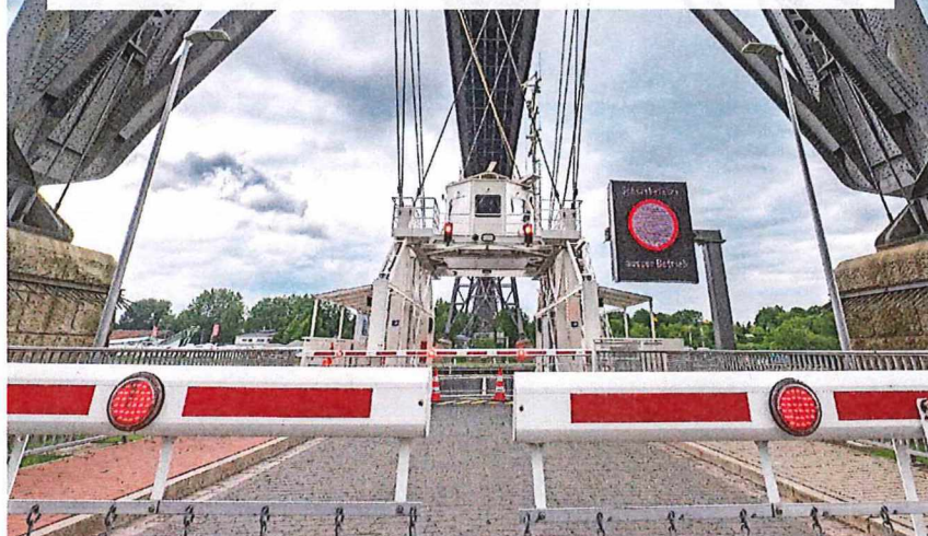
Schranken geschlossen, alle Lichter auf Rot: die Schwebefähre im Ruhezustand.
